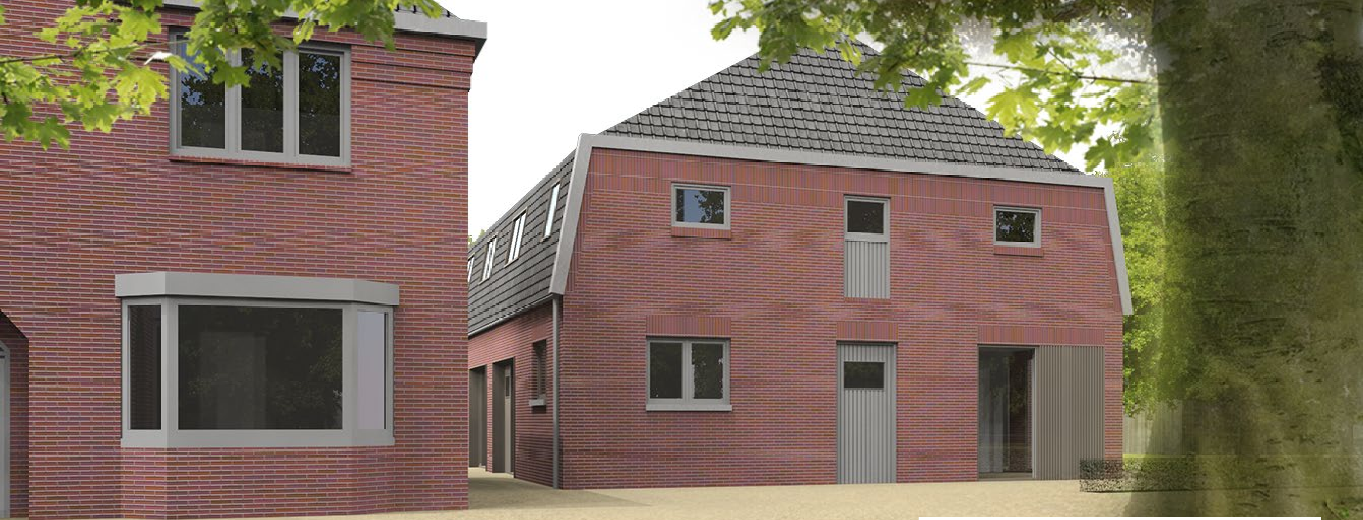
impressie van de veestal vanaf de oprijlaan
